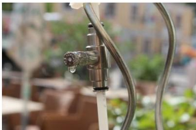
Abbildung 6: Düse einer Wasservernebelungsanlage (Quelle: EIGENE AUFNAHME 2017)
