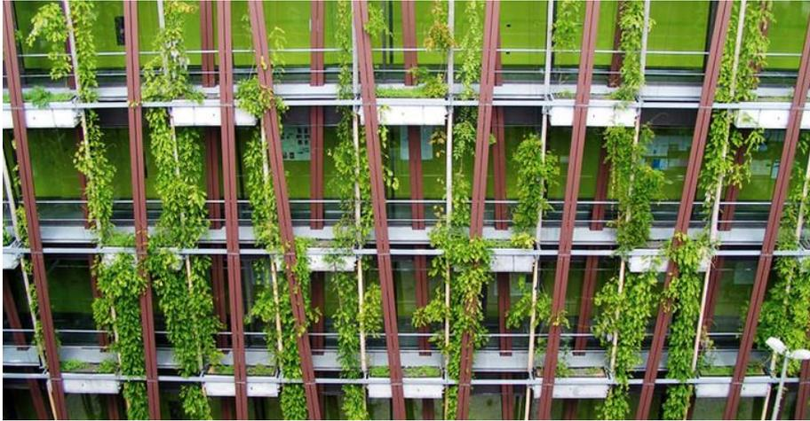
Abbildung 9: Bodengebundene Fassadenbegrünung (Quelle: SCHMIDT 2014)
