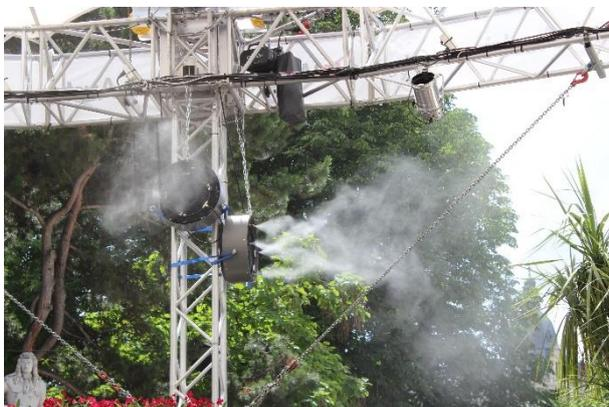
Abbildung 2: Fix installierter Nebelventilator am Rathausplatz, Wien. (Quelle: EIGENE AUFNAHME 2017)
